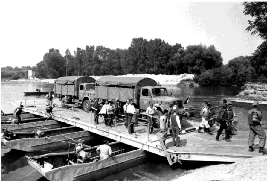
Aufgebaute Pontonfähre bei einer Übung in Deutschland
